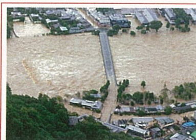
↑7 2013年台風18号による河川の氾濫(京都府京都市)
