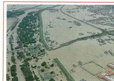
↑7 平成30年7月豪雨による河川の氾濫(岡山県倉敷市, 2018年)
